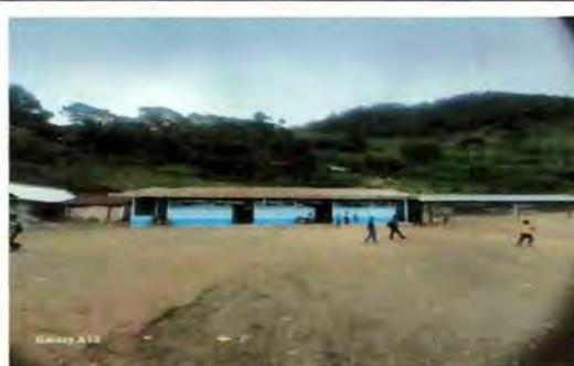
Foto 6: En la actualidad solo se cuenta con una cocina con cimiento de concreto, con el fondo de remozamiento se estará mejorando la cocina.
